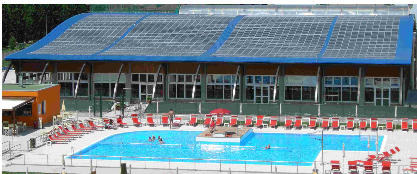
Piscina Comunale di Fossano - Impianto Fotovoltaico da 144,5 kWp realizzato nel maggio 2008 a cura della ECOTECNICA per conto di VIVI SPORT - UISP
