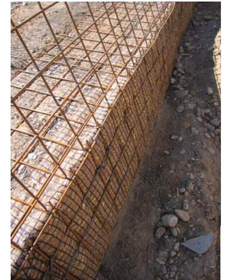
Manufatti in terra rinforzata per il ripristino di un sottoscarpa stradale;
